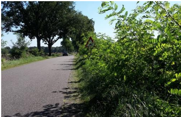
Een voorbeeld van achterstallig onderhoud van het gemeentelijk groen in de berm: verkeersborden zijn niet meer te lezen en ook zijn de uitwijkmogelijkheden van (landbouw-)verkeer hierdoor beperkt
